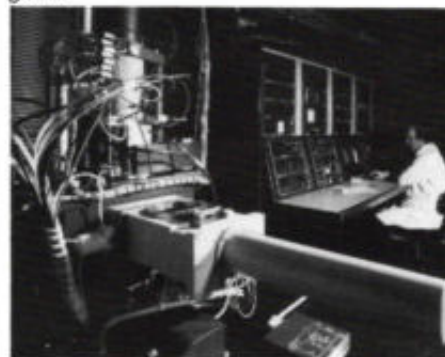
Door Philips ontwikkelde elektronenbundel-schrijver, die patronen kan schrijven van 0,1 \mu\text{m} en zowel geschikt is voor maskervervaardiging als voor het direct schrijven van structuren op wafers.
